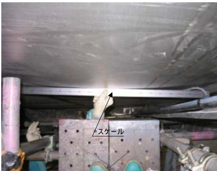
使用済燃料受入れ・貯蔵施設燃料送出しピット斜路 補修を行う既設ライニングプレートの変形状況
