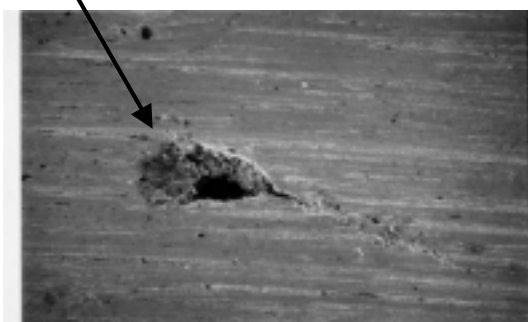
貫通欠陥1 表面拡大写真
