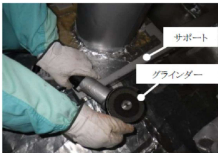
災害発生前状況写真(再現)
