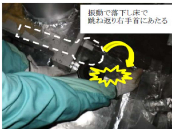
災害発生時状況写真(再現)
