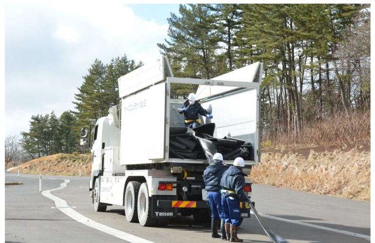
大型移送ポンプ用ホース展張
