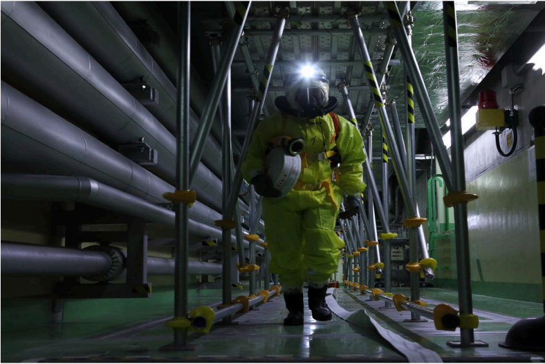
蒸発乾固対策におけるホース展張
