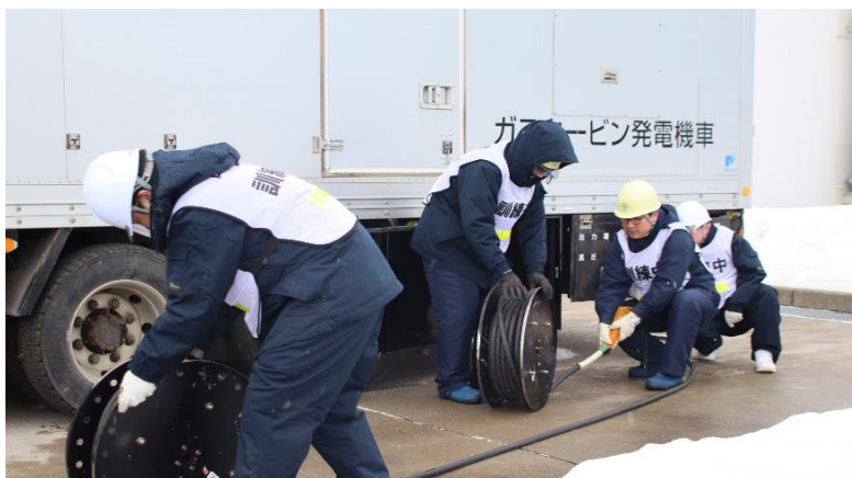
工場への電力供給のため、電源ケーブルを敷設します
