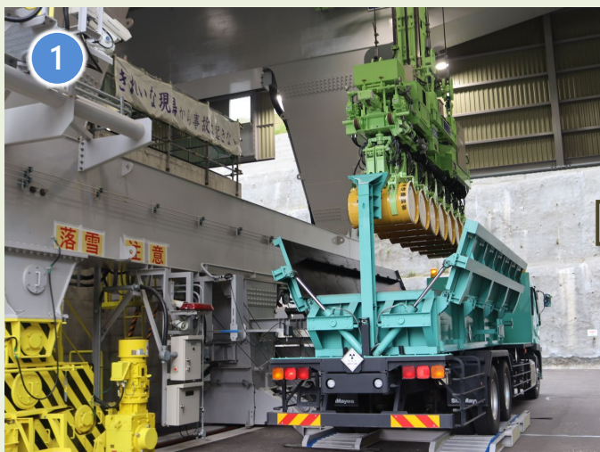
1 検査を終えた廃棄体をクレーンで持ち上げ埋設設備へ移動
