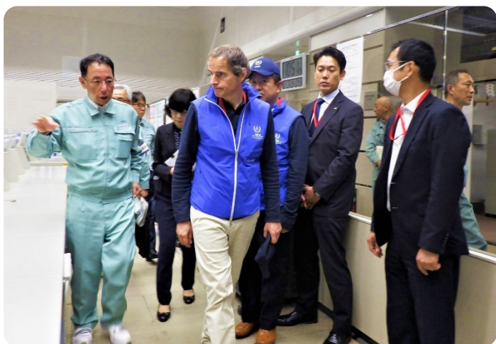
再処理工場の中央制御室
