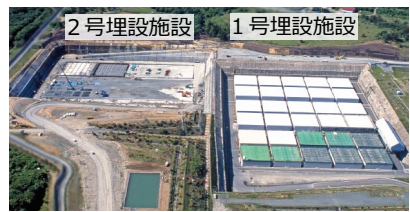
2号埋設施設工事中の全景 (1998年)
