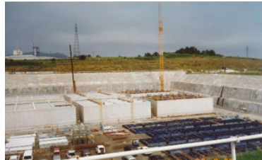
1号埋設施設建設工事の様子 (1992年)
