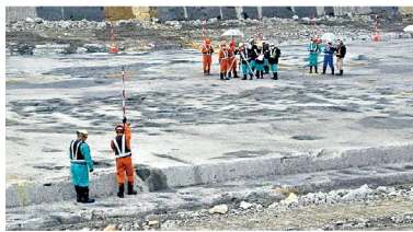
3号埋設施設 本格工事開始 (2021年)
