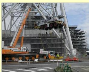
竜巻による飛来物から主排気筒を守るため、飛来物防護板を設置。
