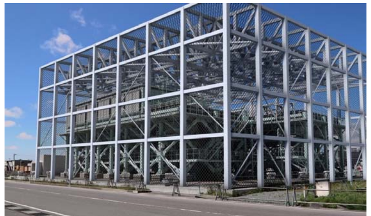
冷却塔への飛来物防護ネット設置（CGイメージ）
