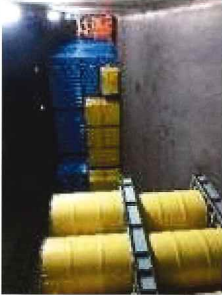
コンテナ保管室
