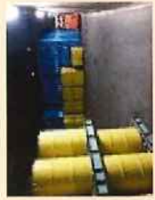
コンテナ保管室
