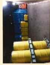
コンテナ保管室
