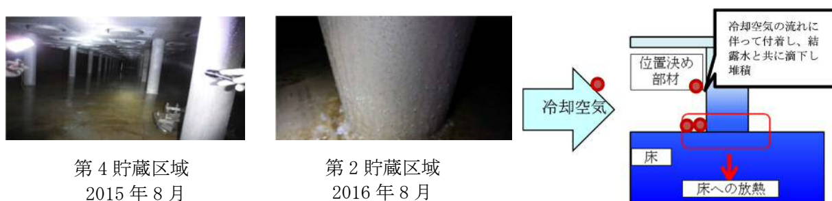
図-10 下部プレナムに確認された結露状態および付着イメージ図
