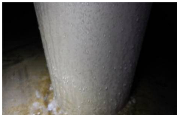
第2貯蔵区域 2016年8月 (位置決め部材表面に結露を確認)
