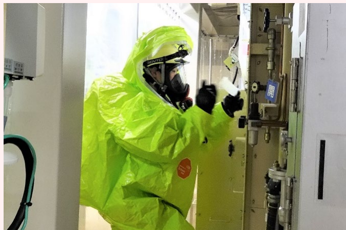
防護服を装着した設備応急班が六フッ化ウランの漏えい箇所を養生し塞ぐ様子
