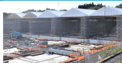
1号埋設施設（1～4群）
