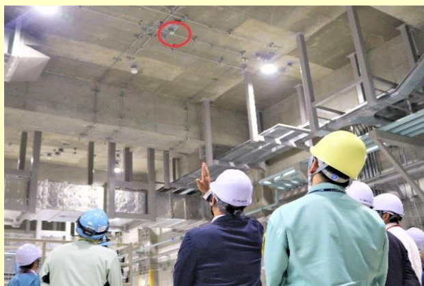
④ 火災報知器の点検業務の様子
