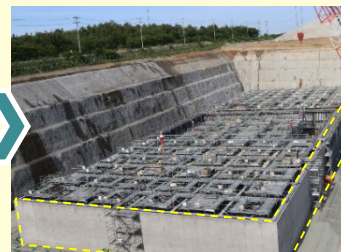
ピット側壁のコンクリート打設 (2023年6月)
