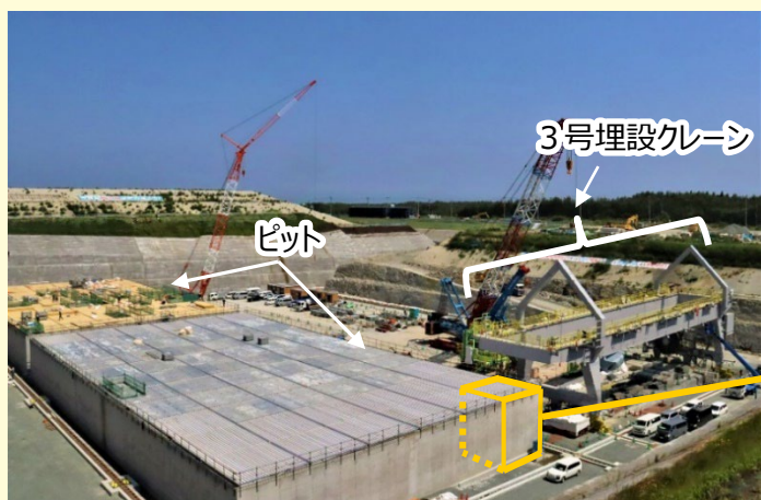
3号埋設施設の全景
