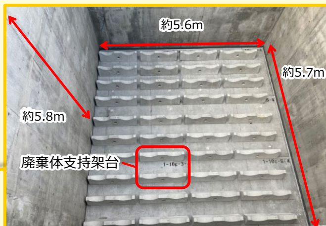
区画内の廃棄物支持架台の設置状況
