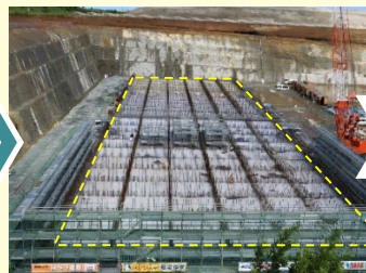
ピット底版のコンクリート打設 (2022年8月)
