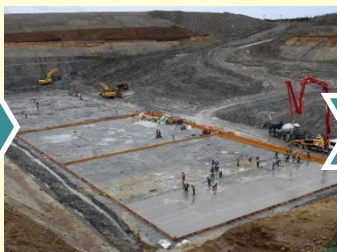
岩盤へのコンクリート打設 (2021年11月)
