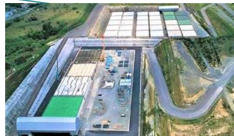
2号埋設施設の操業開始直前の様子(2000年撮影)
