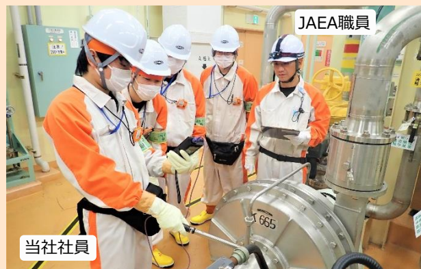
排風機の点検を行う様子
