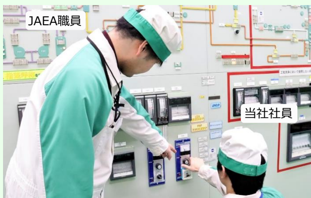
脱硝塔へ供給するウラン溶液の流量を調整する様子
