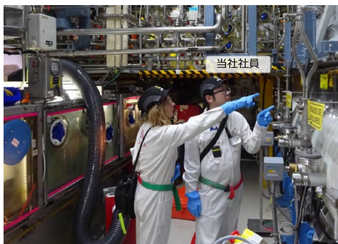
当社社員 現場でペレット焼結炉の稼働状況を確認している様子
