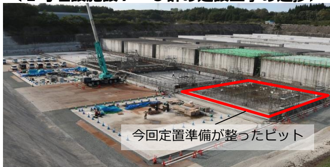
ピットの底版コンクリート打設(2021年9月)
