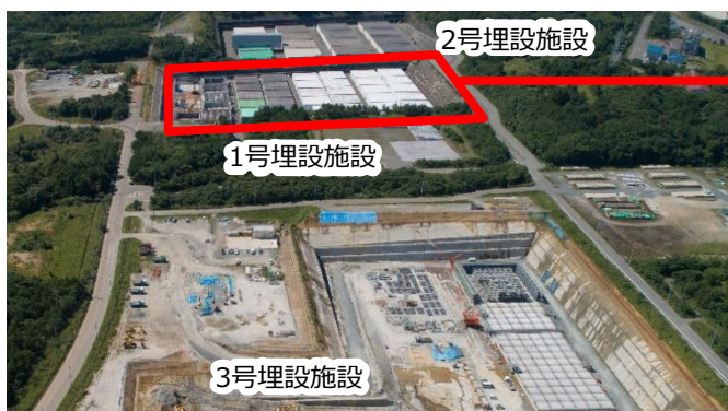
埋設施設の全景(2022年9月時点)
