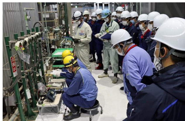
協力会社社員が圧力計の点検作業を行っている様子
