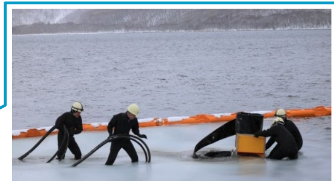
尾駮沼に水中ポンプを投入する様子
