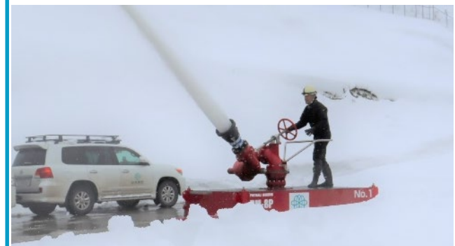
放水砲で放水する様子
