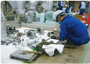
ポンプ分解点検作業
