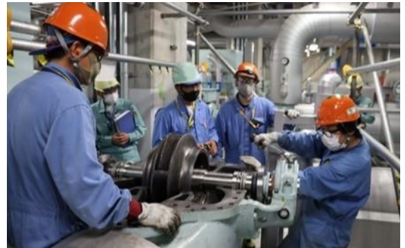
地元企業の方々が再処理工場内の設備保全を行う様子
