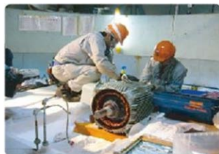
モータ分解点検作業
