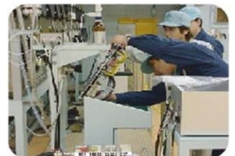
制御盤内の電池交換作業
