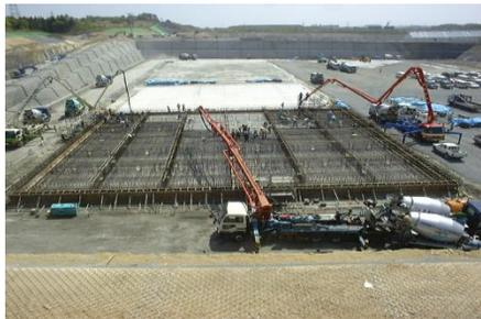
②ピットの底版コンクリート打設
