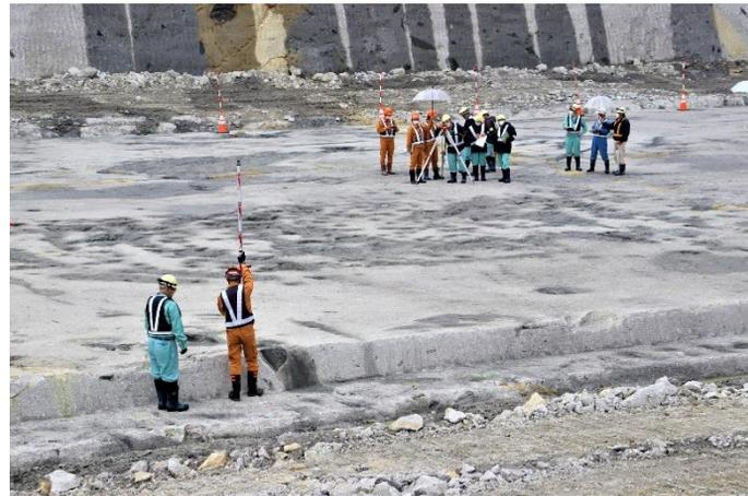
10月26日の岩盤検査の様子（岩盤面の深さを測量により確認している様子）
