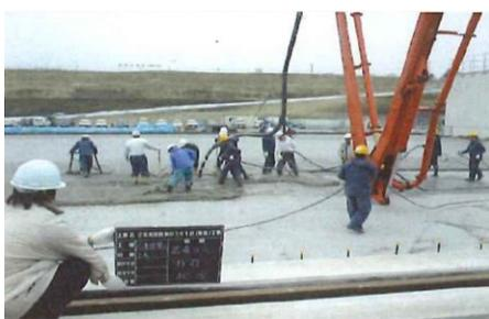
①岩盤へのコンクリート打設
