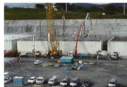
③ピットの側壁等のコンクリート打設
