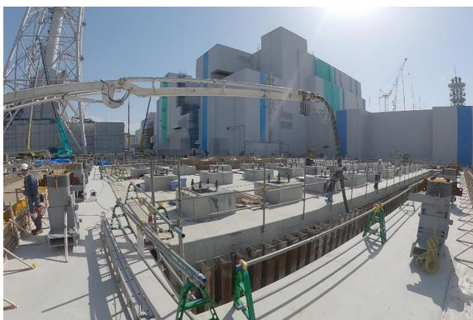
④冷却塔設置のための架台部を構築（2021年5月）
