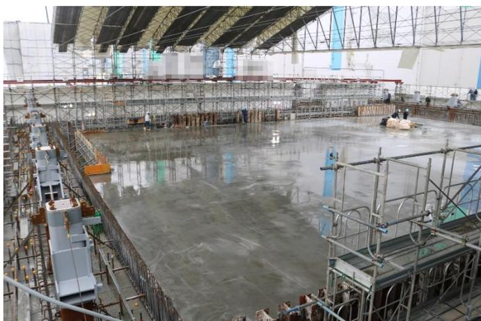
②人工岩盤のコンクリート打設完了（2021年3月）
