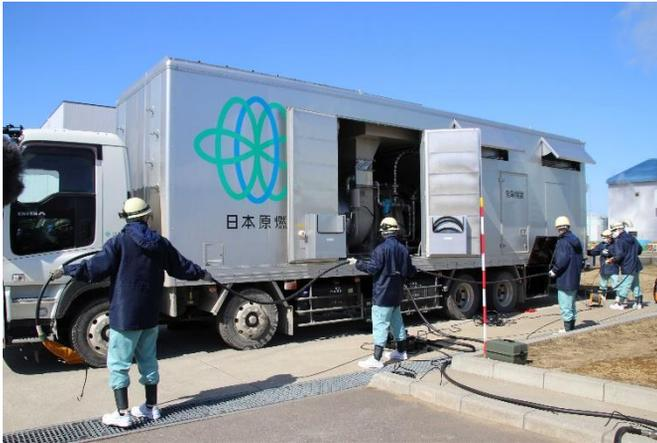
電源車から非常用電源建屋へ電気を送るためのケーブルを敷設する様子
