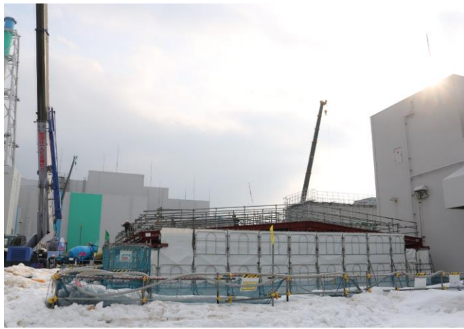
非常用電源建屋冷却塔工事現場での屋根設置の様子（2021年1月撮影）
