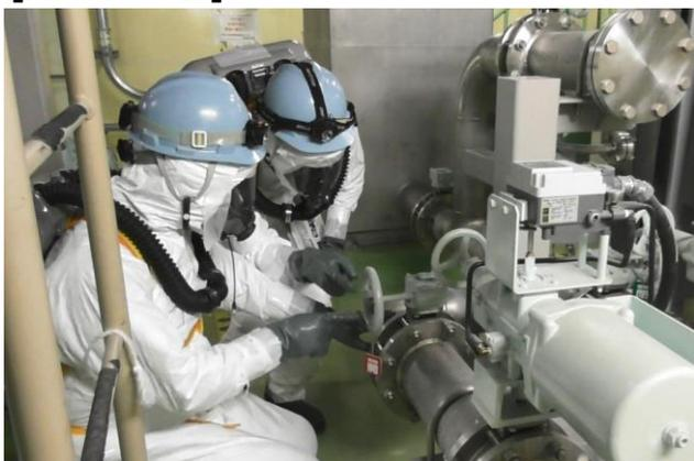
放射性物質を建屋内に閉じ込めるため、廃ガス処理設備の弁を閉止操作する様子
