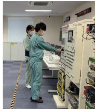
現場を模擬した制御盤や機器が中央制御室での運転操作により正常に作動しているかを確認
