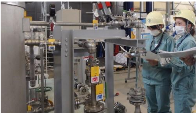
目視による設備の状態確認
