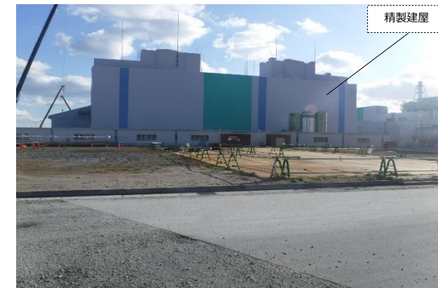
工事实施前の状況
