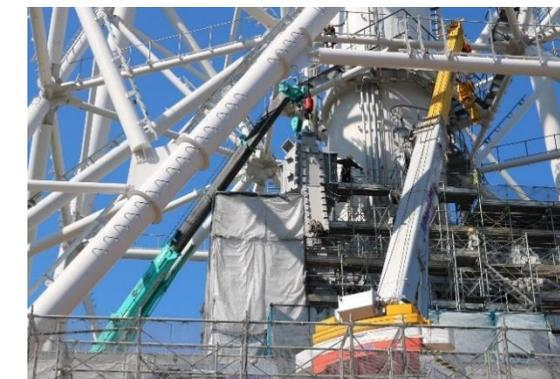
小型クレーンで鉄骨を設置
