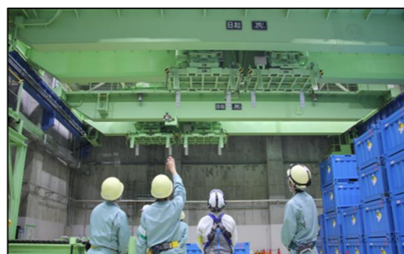
天井クレーンの部品交換後の動作確認 (低レベル廃棄物管理建屋)
