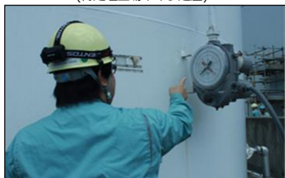
オイルタンクの液位を確認 (ウラン濃縮工場)
