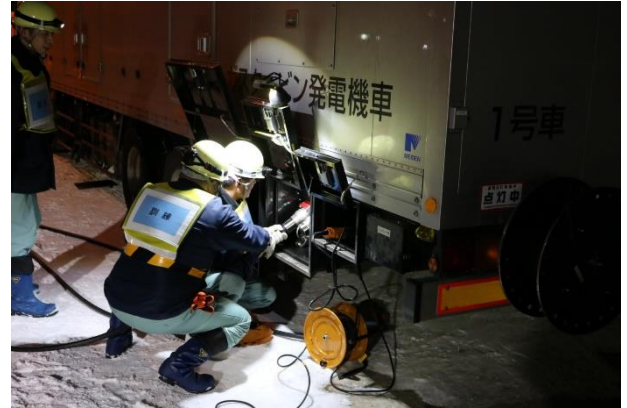
電源車へのケーブルの繋ぎこみ
