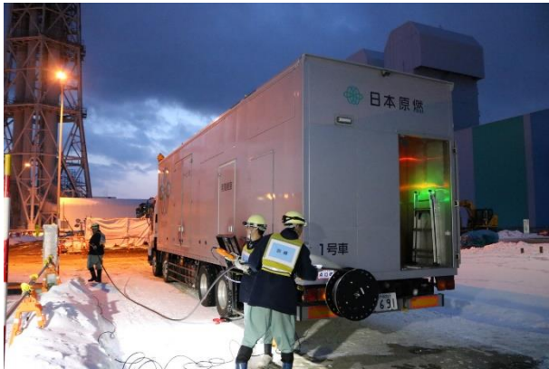
電源車から建屋にケーブルを敷設
