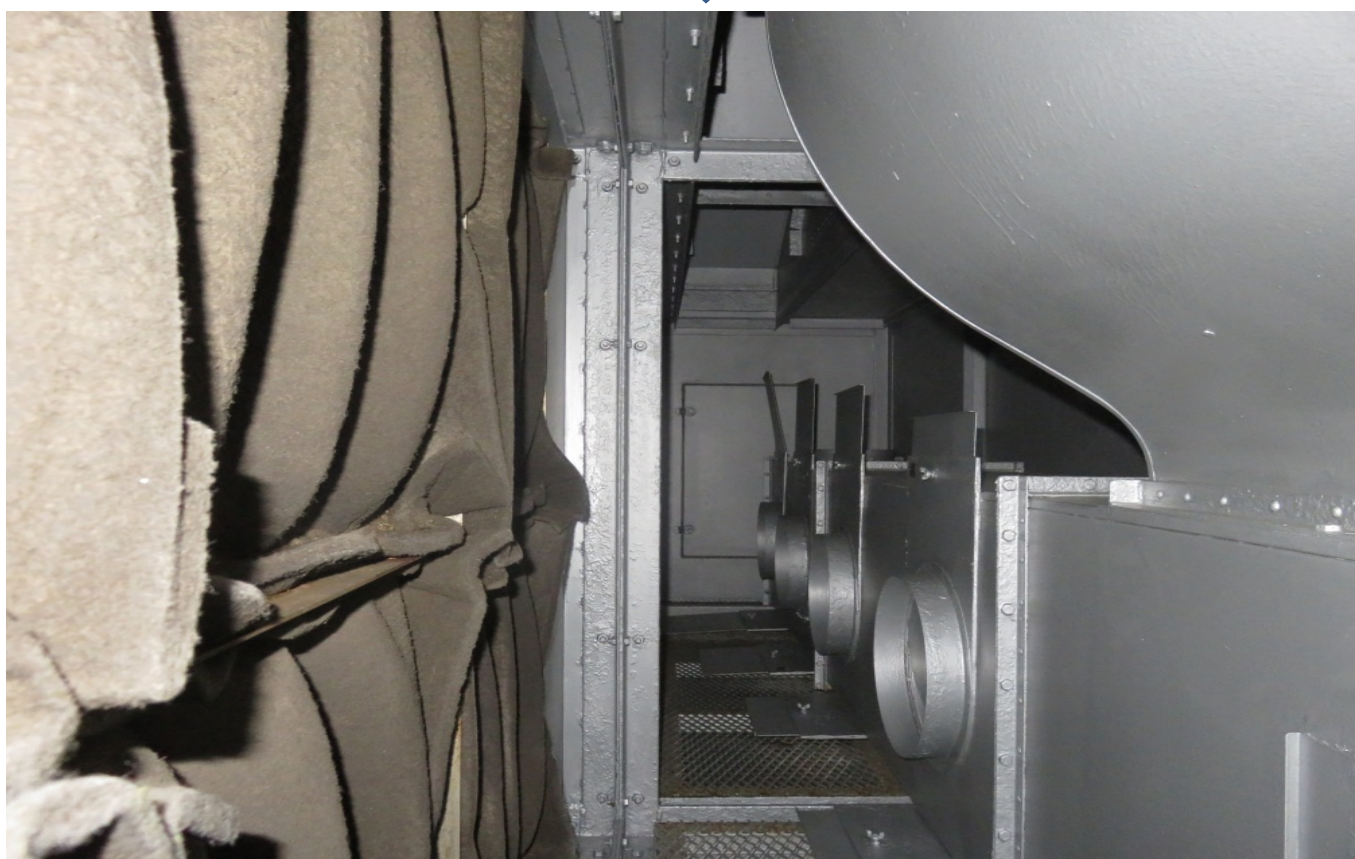
ウラン濃縮工場 2階 給気室 (10/23 撮影)
