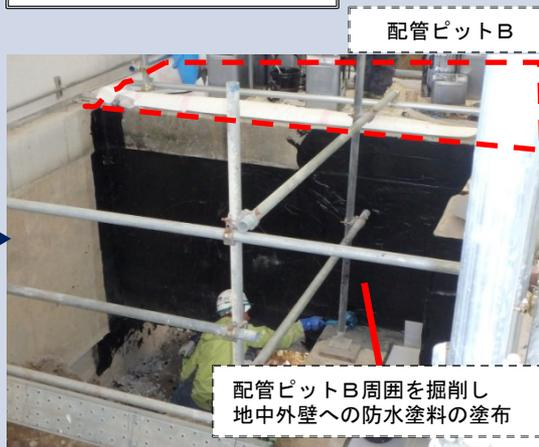
雨水浸透防止のための配管ピット周辺地盤埋め戻し
