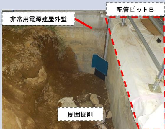
雨水浸入防止強化のための配管ピット躯体への防水措置
