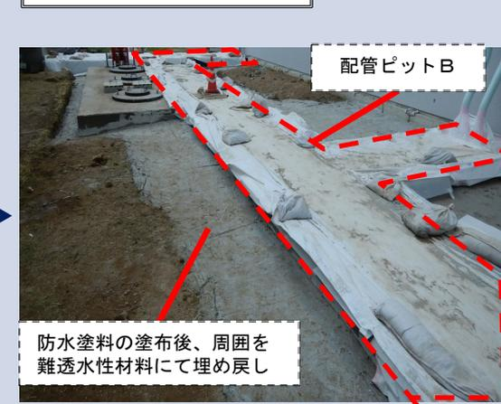
雨水浸入防止強化のための配管ピット点検口のパッキン交換
