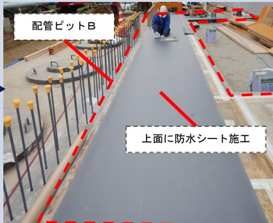
雨水浸透防止のための配管ピット周辺地盤のコンクリート舗装準備
