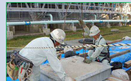
点検口以外はコンクリート蓋で閉鎖されており、開放が容易ではない
