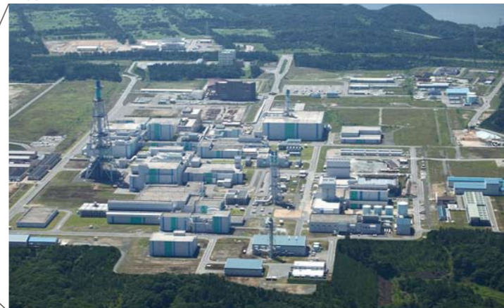
■再処理工場の全景
