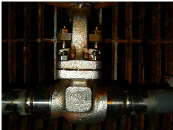
【漏えい弁の状況】
