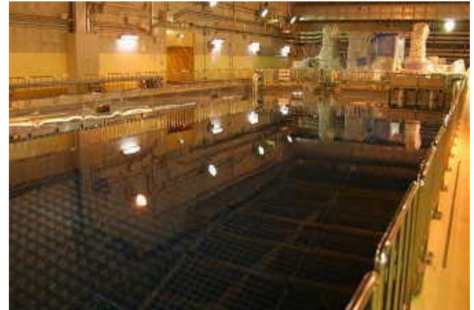
補修完了後の燃料貯蔵プールの様子
