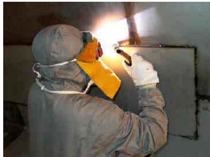
補修作業の様子
