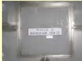
補修作業後の様子
