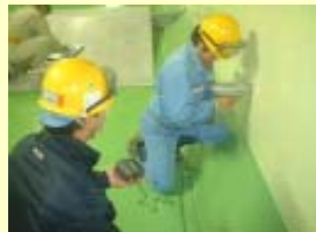
現品点検 成分分析計を用いて材質を確認している様子
