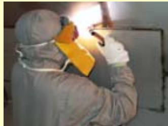
補修作業の様子
