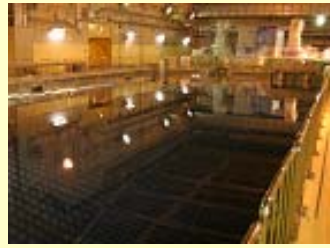
補修終了後の貯蔵プール
