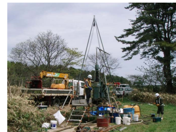
図-3 ボーリング調査の例
