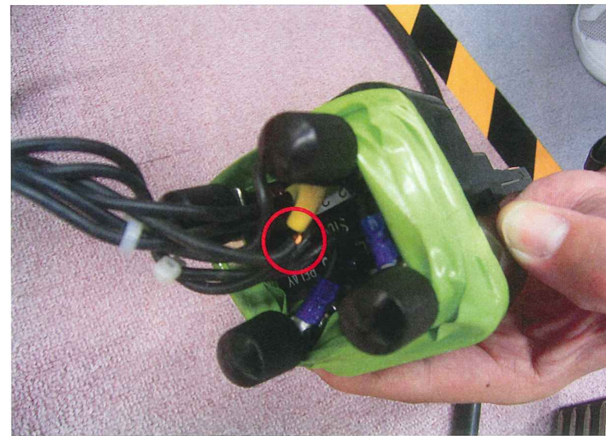
④ 電流プラグ結線部ケーブル断線箇所
