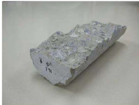
図5 採取したコンクリートコア断面の状況
