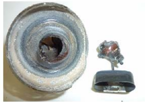
溶融損傷した側の電極部
