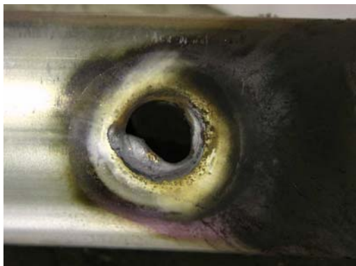
電線管（再現試験）
