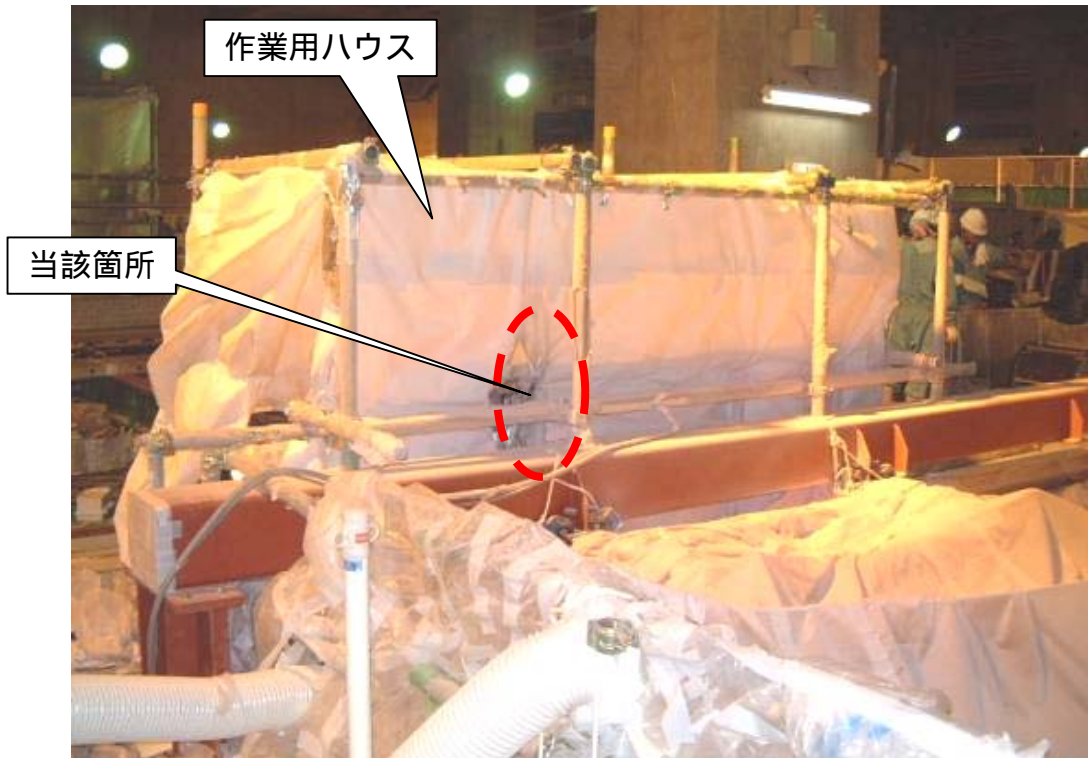
作業用ハウス全体(北東側から見た状態)
