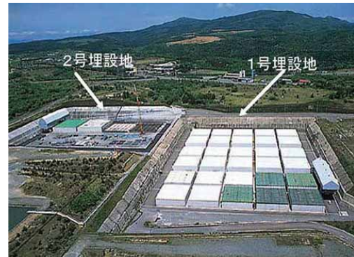
(低レベル放射性廃棄物埋設センター 全景)
