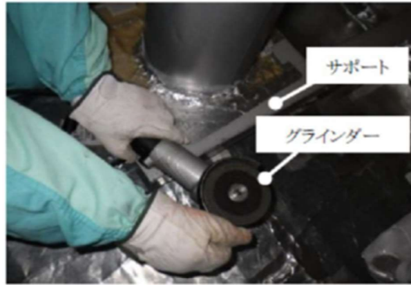
災害発生前状況写真(再現)
