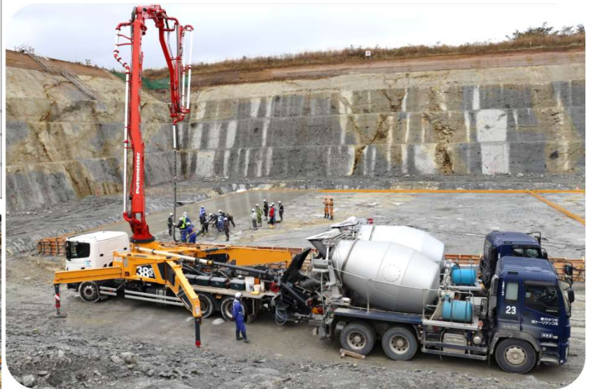
11月12日に開始した岩着コンクリート打設の様子
