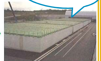
④完成！ (8つのピットを構築)
