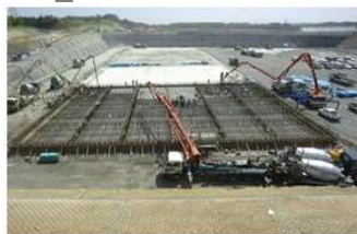
①ピットの底版コンクリート打設
