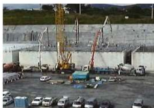
②ピットの側壁等の コンクリート打設
